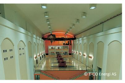
Das Kraftwerk wurde 1953 in Betrieb genommen und 1989 modifiziert und erweitert. Es nutzt eine Fallhöhe von 448 Metern und verfügt über vier Francis-Turbinen mit einer Leistung von jeweils 50 MW. Eine weitere Turbine mit einer Leistung von 100 MW wurde bei der Modernisierung 1989 eingebaut.
